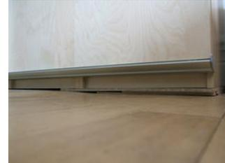
Un petit morceau de ruban métallique ([www.supermagnete.ch/fre/M-FERROTAPE](http://www.supermagnete.ch/fre/M-FERROTAPE)) ainsi que deux aimants plats ([www.supermagnete.ch/fre/Q-10-05-1.5-G](http://www.supermagnete.ch/fre/Q-10-05-1.5-G)) fixés avec du cimentite éliminent cet inconvénient.
