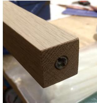
Bei dieser Installation gilt es zu beachten, dass die grösste Schwäche der Topfmagnete wohl das Kippmoment ist. Bei einem Kipphebel von 48.5 cm (die Hälfte der Leistenlänge) könnten die Magnete am ehesten noch durch eine Wippbewegung an der Leiste zum Abkippen gebracht werden.
